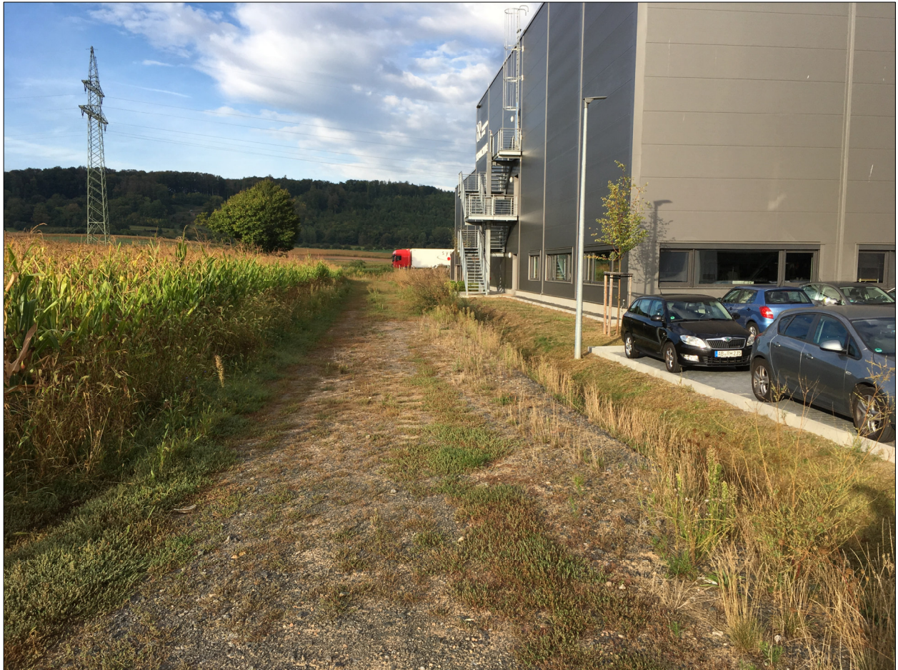
Abb. 7: Schotterweg auf der Trinkwasserleitung zwischen bestehenden Betriebsgebäuden und der angrenzenden Ackerfläche.
